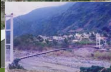
於風災中被沖毀的拉灣橋昔日原貌
